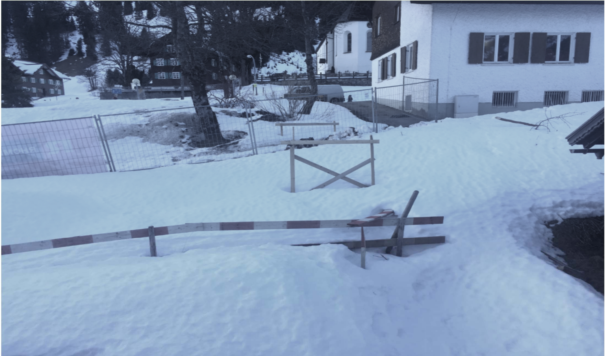
Barrierefreier Zugang Richtung Ortsmitte
